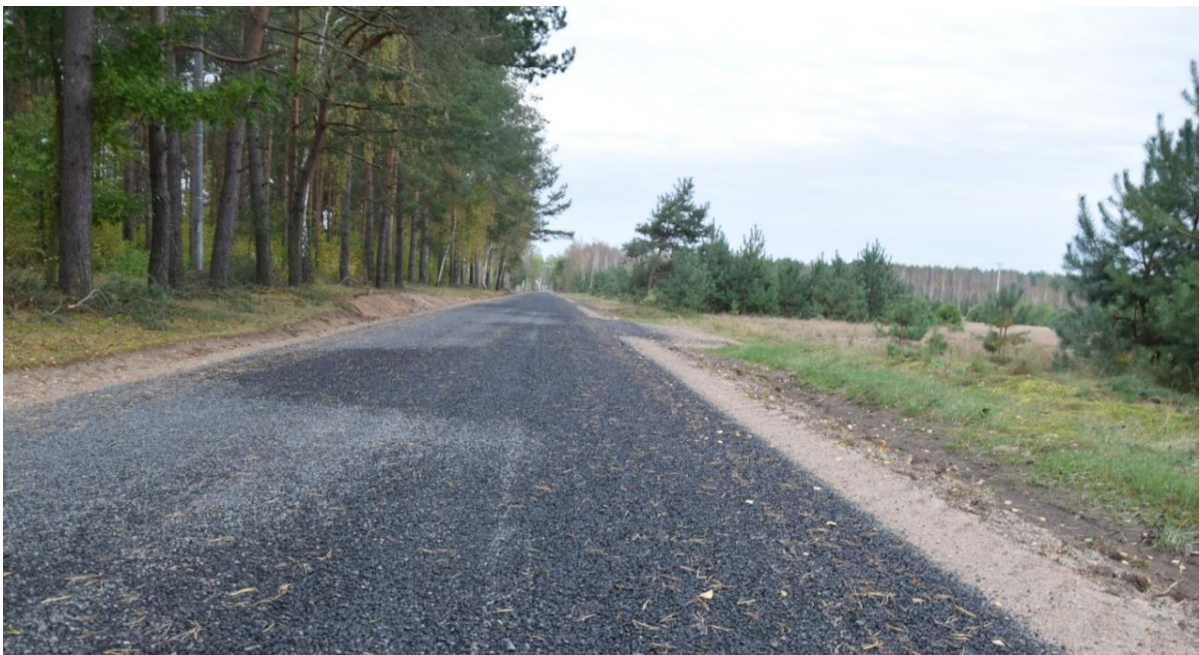
/Zdjęcie własne: przebudowana droga w miejscowości Telążna Leśna/
