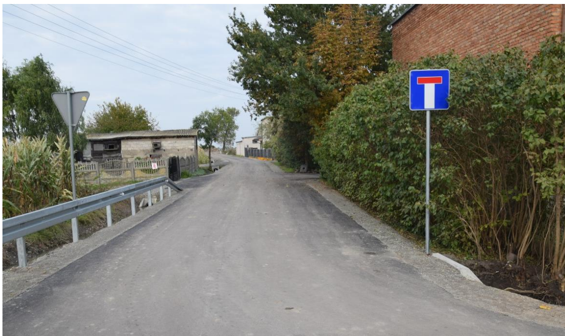
/Zdjęcie własne: przebudowana droga w miejscowości Gróbce
