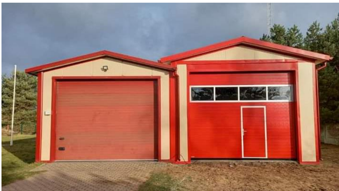
/Zdjęcie własne: rozbudowany o pomieszczenie gospodarcze garaż Ochotniczej Straży Pożarnej Dąb Polski/
