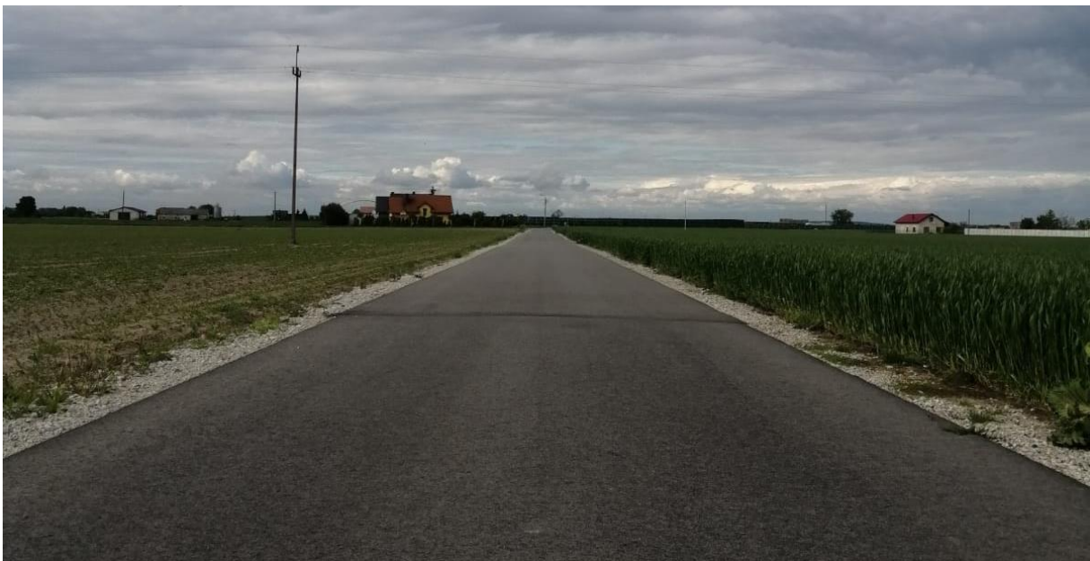
/Zdjęcie własne: droga gminna w miejscowości Ludwinowo/
