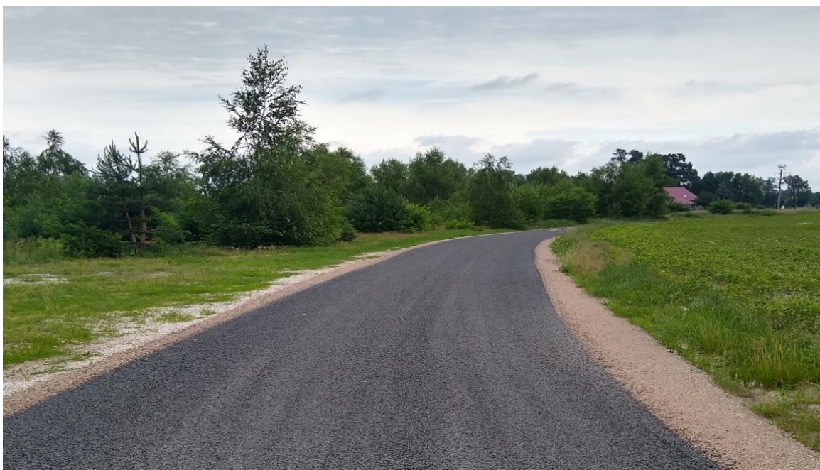
/Zdjęcie własne: przebudowana droga w miejscowości Józefowo/
