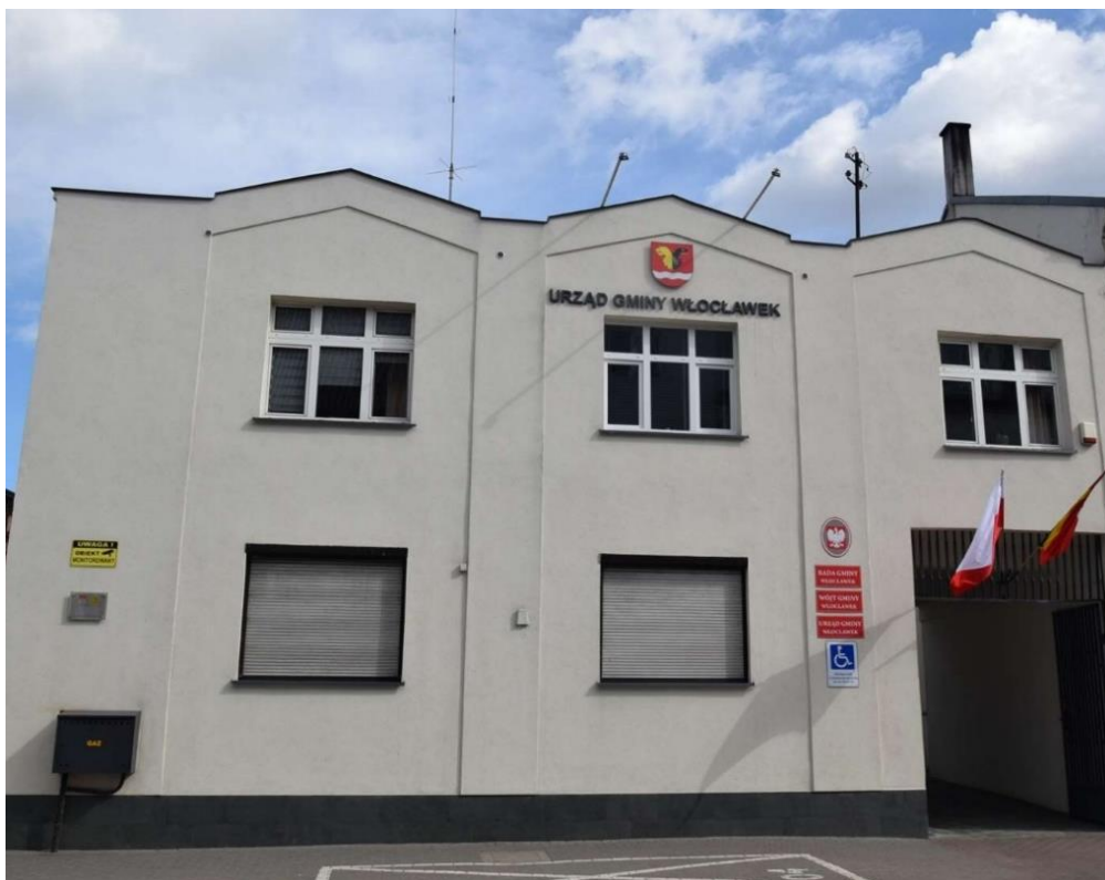
/Zdjęcie własne: Urząd Gminy Włocławek – widok od ul. Królewieckiej/
