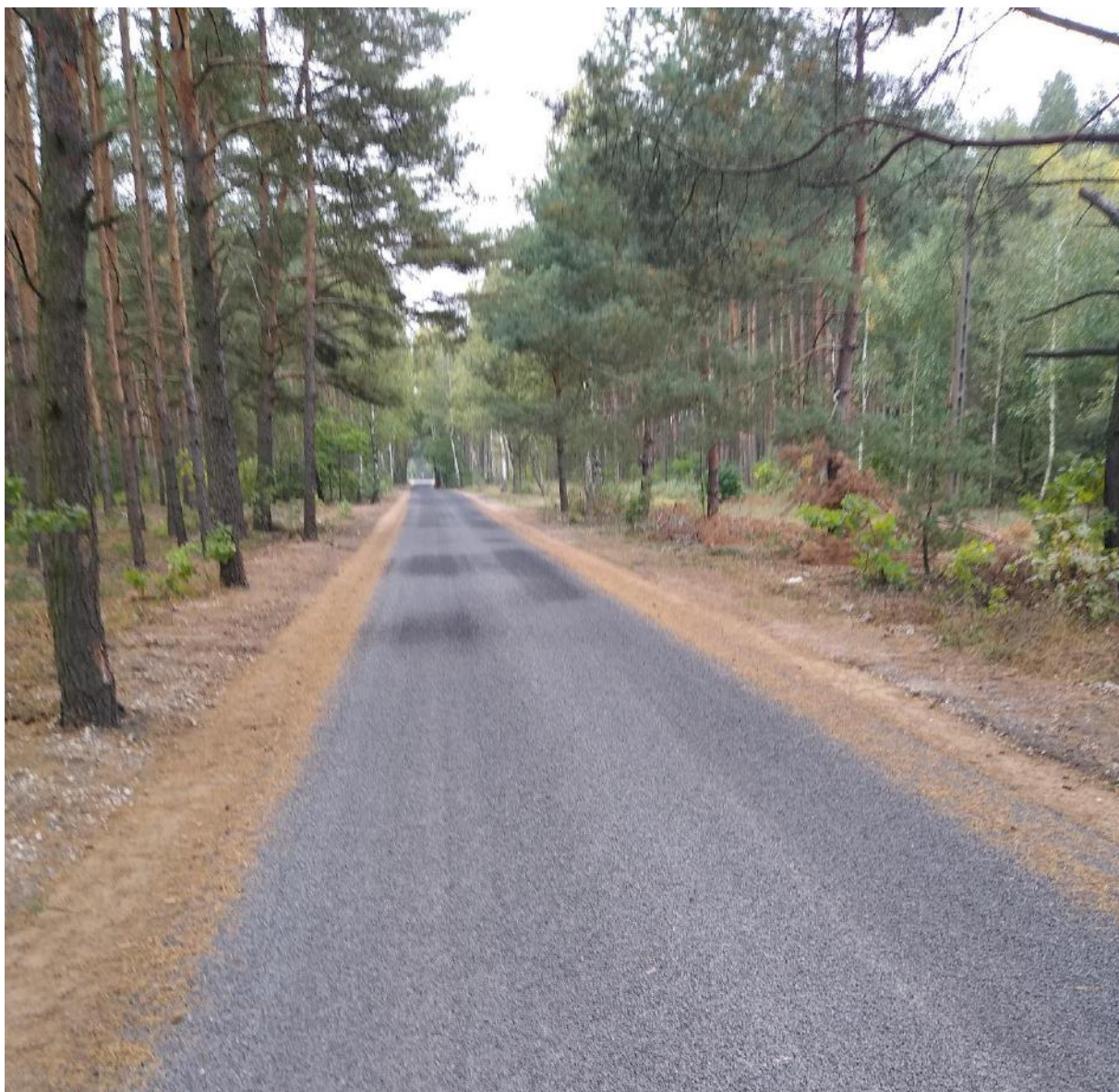
Przebudowana droga w miejscowości Telążna Leśna.
