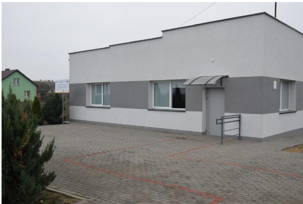
Świetlica wiejska w miejscowości Koszanowo po przeprowadzonej termomodernizacji.
