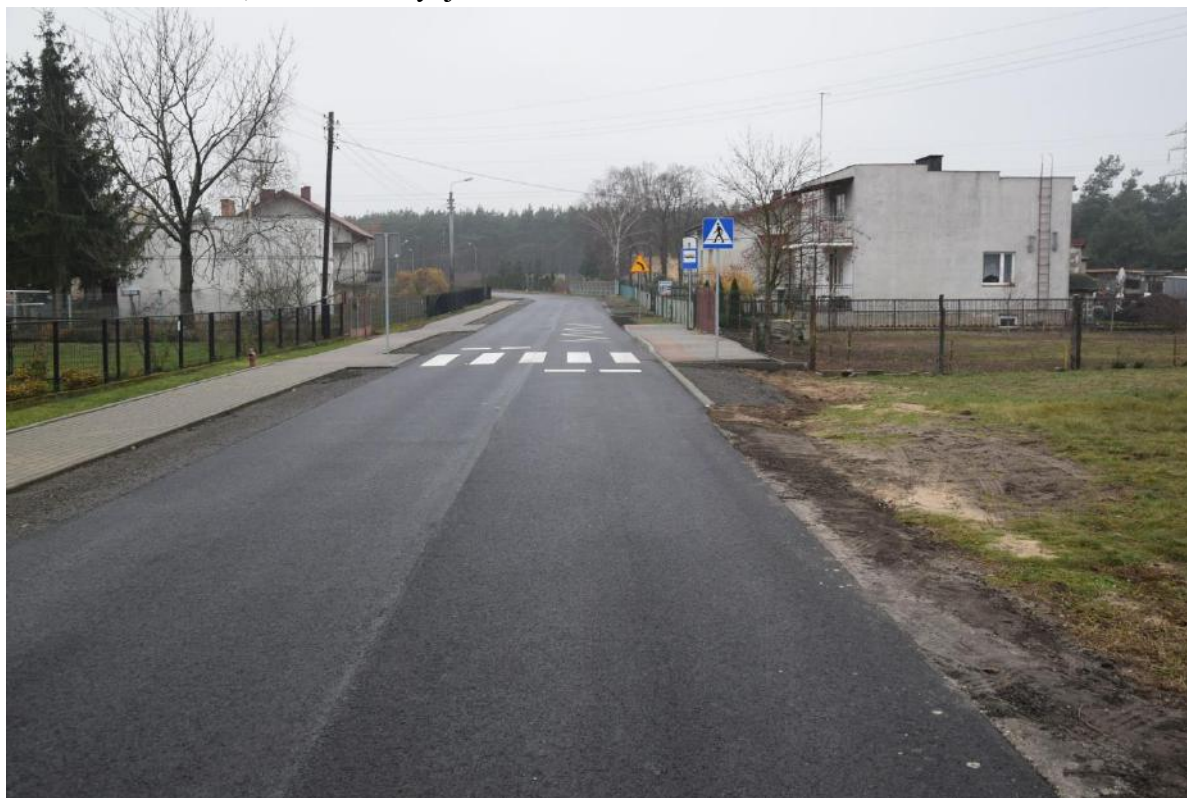
Wyremontowana droga gminna nr 190518 Jedwabna – Warząchewka Nowa – Łagiewniki od km 2+498 do km 3+176 dł. 678 m.
