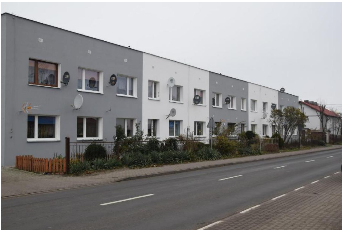
Blok wielorodzinny w miejscowości Kruszynek po termomodernizacji
