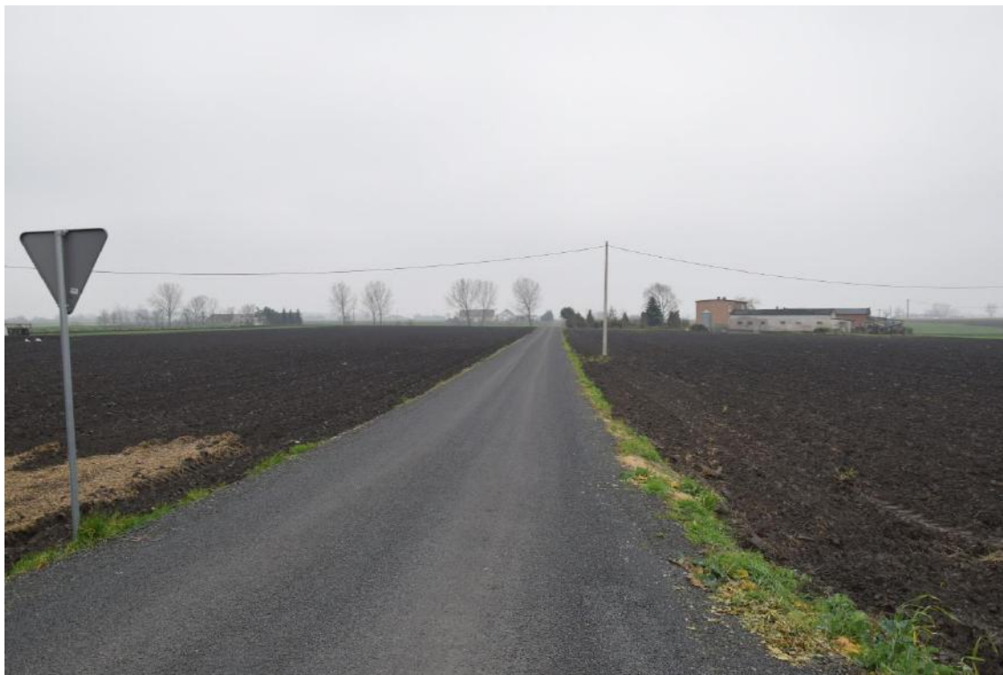
Przebudowana droga w miejscowości Sykuła.
