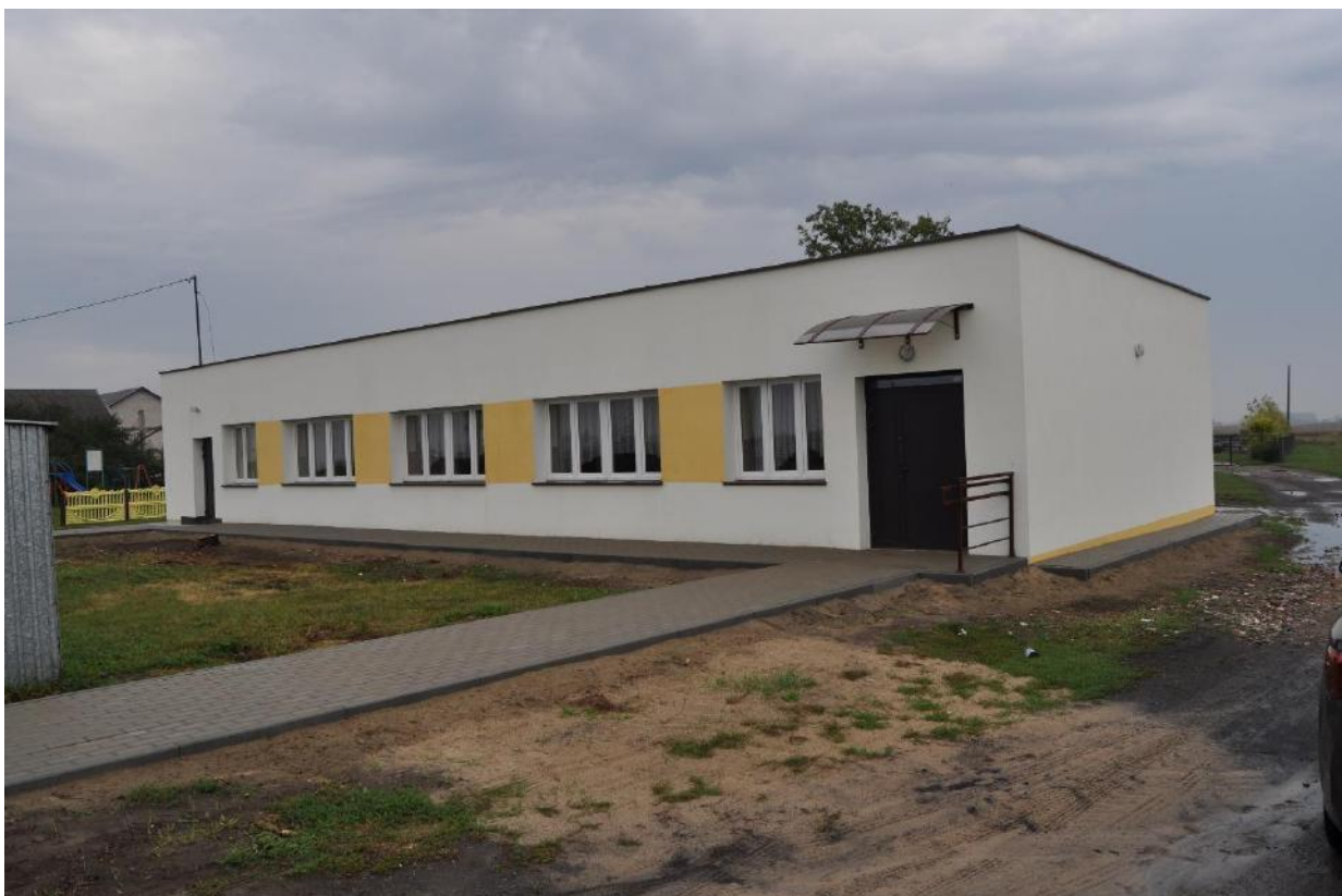
Świetlica wiejska w miejscowości Poddębice po przeprowadzonej termomodernizacji.
