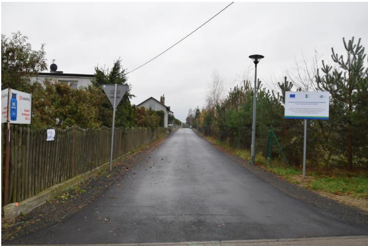
Przebudowana droga gminna w miejscowości Modzerowo.
