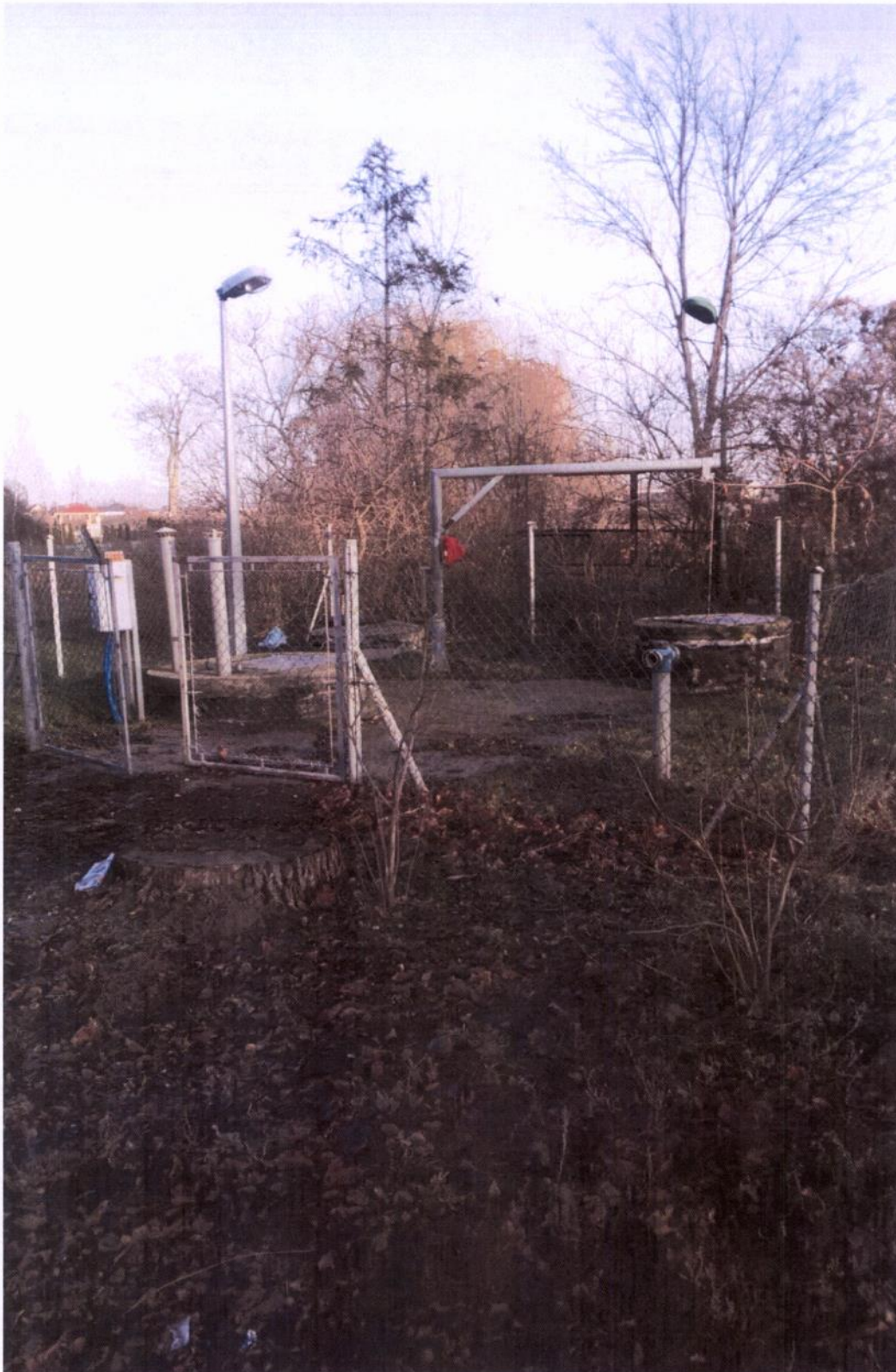
Rysunek 47. Przepompownia Świątosław 2 źródło: Stacja Uzdatniania Wody Dębice
