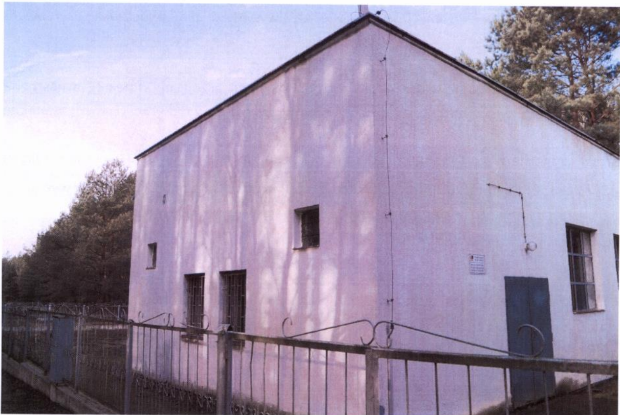
Rysunek 6. Stacja Uzdatniania Wody w Smólniku budynek bok źródło: opracowanie własne
