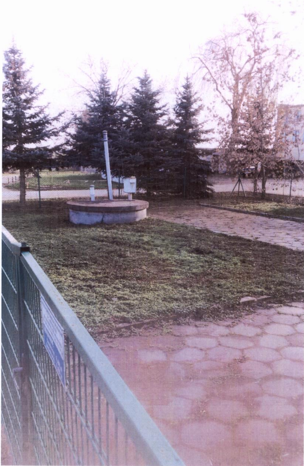
Rysunek 45. Przepompownia Kruszynek źródło: Stacja Uzdatniania Wody Dębice
