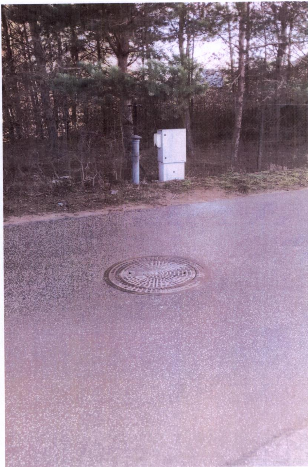
Rysunek 42. Przepompownia w Nowej Wsi źródło: Stacja Uzdatniania Wody Dębice
