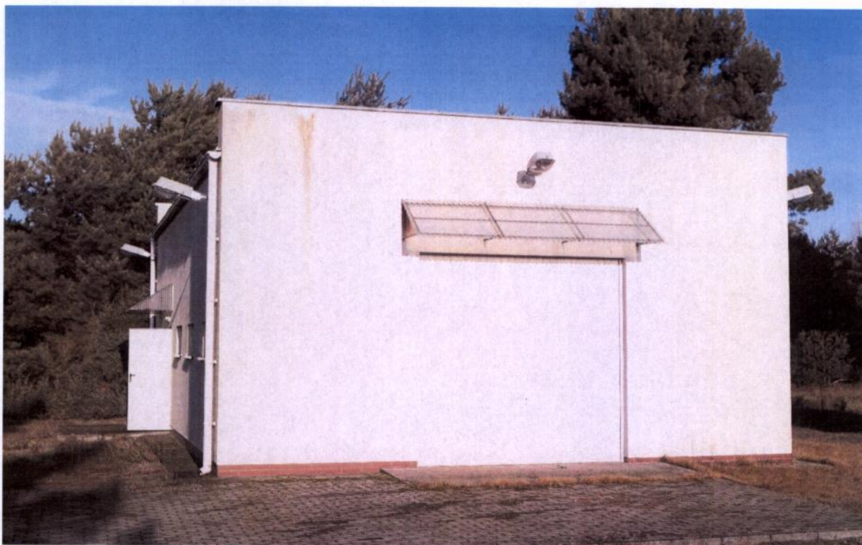
Rysunek 15. Stacja Uzdatniania Wody w miejscowości Dqb Polski- bok budynku źródło: opracowanie własne
