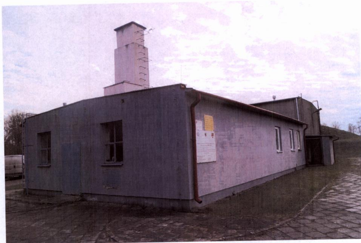
Rysunek 26. Stacja Uzdatniania Wody w Dębicach budynek źródło: opracowanie własne
