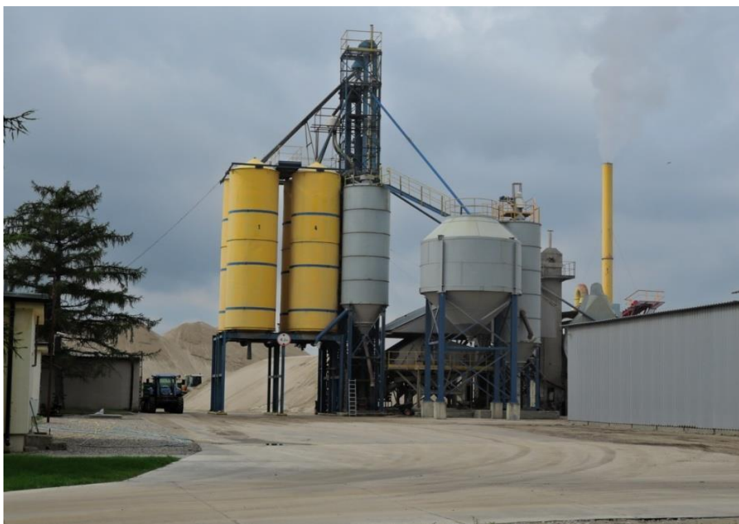
Zdjęcie 3 Zagospodarowanie działki nr ew. 378/7 - obręb Dąb Wielki – hale produkcyjne i magazyny piasku.
