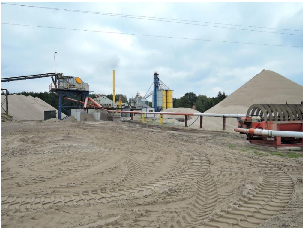
Zdjęcie 1 Zagospodarowanie działki nr ew. 378/7 - obręb Dąb Wielki - place manewrowe i haldy piasku.
