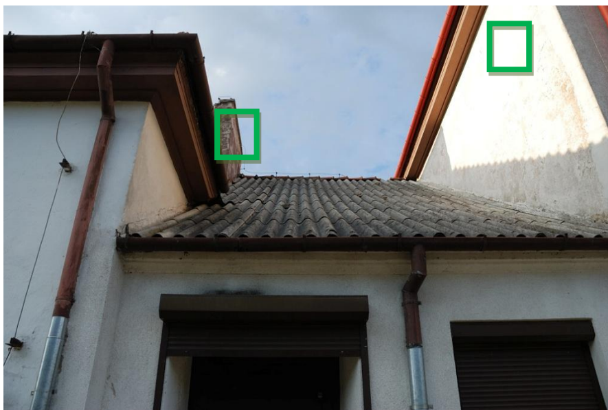
Fot. 36 Elewacja południowa szkoły w Smólniku stanowi miejsce odpowiednie do montażu zastępczych schronów dla nietoperzy – zaznaczono na zielono
