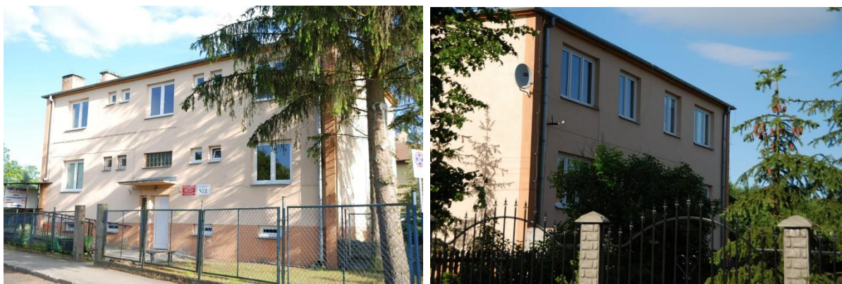
Fot. 15-16 Widok ogólny na budynek ośrodka zdrowia w Smólniku.
