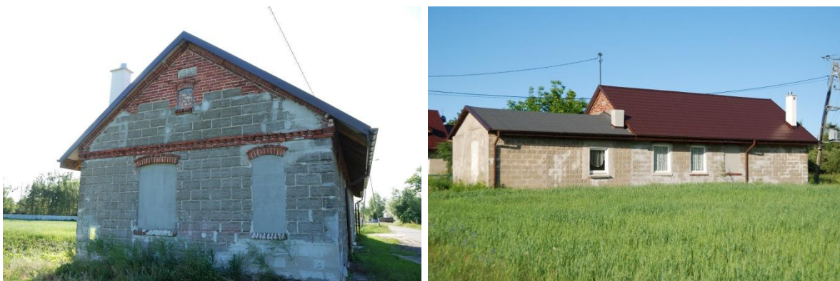
Fot. 17-18 Widok ogólny na budynek świetlicy wiejskiej w Wistce Królewskiej
