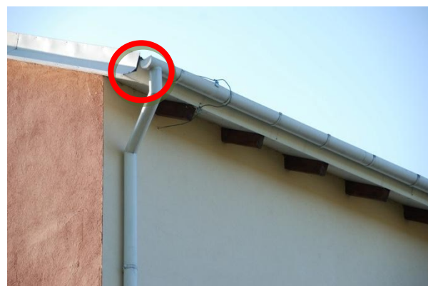
Fot. 4-5 Widok od strony ulicy na halę sportową, zaznaczone stanowisko lęgowe wróbla Passer domesticus
